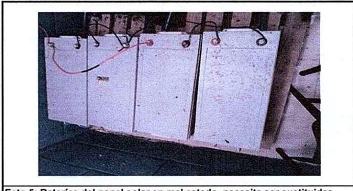
Foto 5: Baterías del panel solar en mal estado, necesita ser sustituidas.
