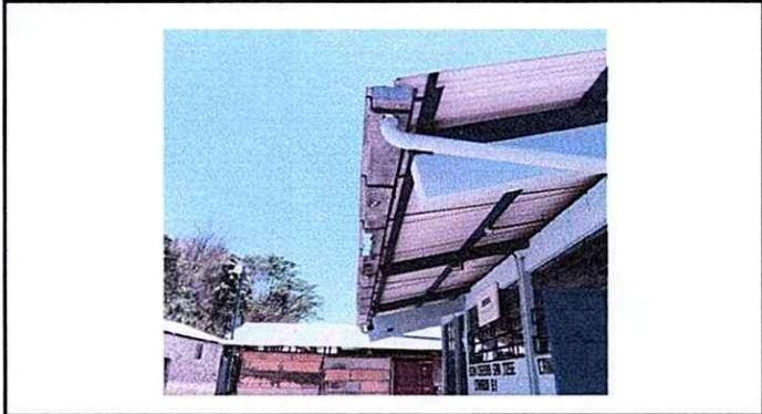
Foto 2: En la foto se observan los canales en mal estado.
